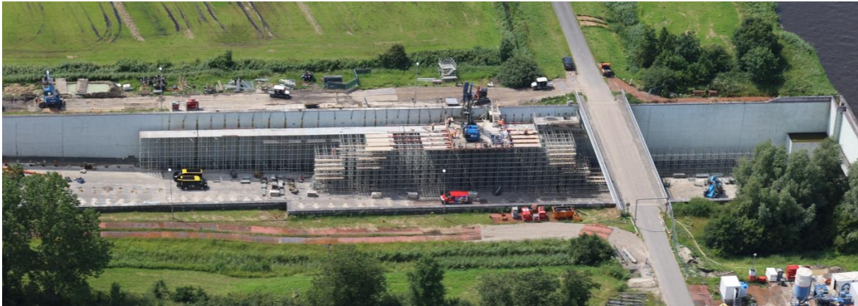
Foto 1 Aanbrengen wandankers (bron: Rijkswaterstaat)
