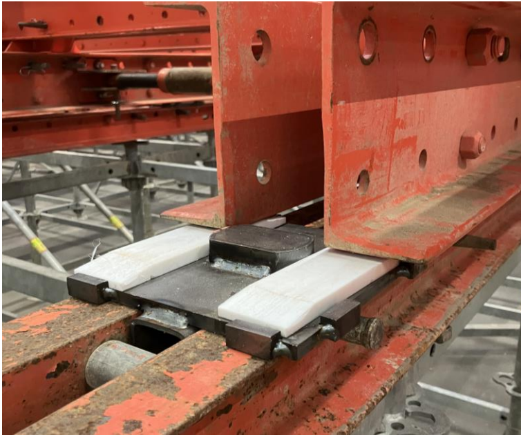
Foto 14 Op de gordingen bevinden zich teflonplaten (bron: PERI)
