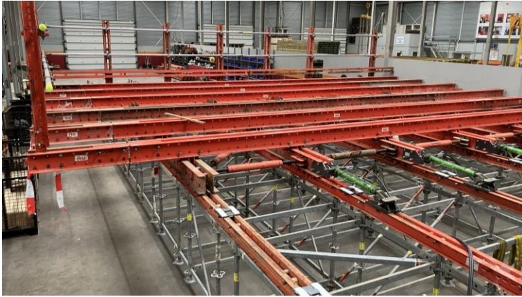
Foto 15 Mock-up platform en ondersteuningssteiger (bron: PERI)
